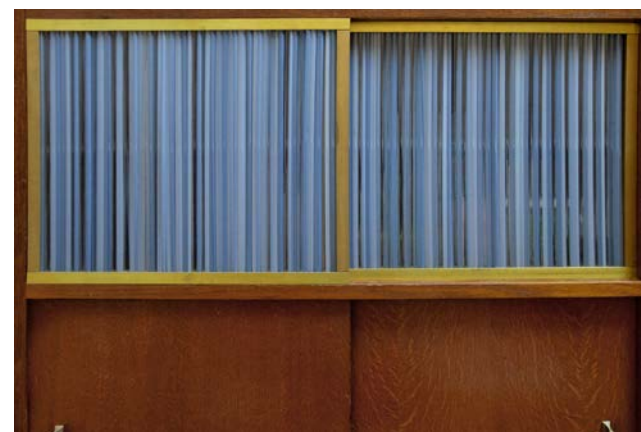
Portes coulissantes de mobilier réalisées par le principe des «Claustras» de verre (baguettes opalescentes de verre coloré assemblées en cadres).
